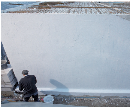
Ein großer Vorteil für den Verarbeiter von CP 1: Werkzeuge sind einfach mit Wasser zu reinigen. (Foto: Ceresit Bautechnik)
